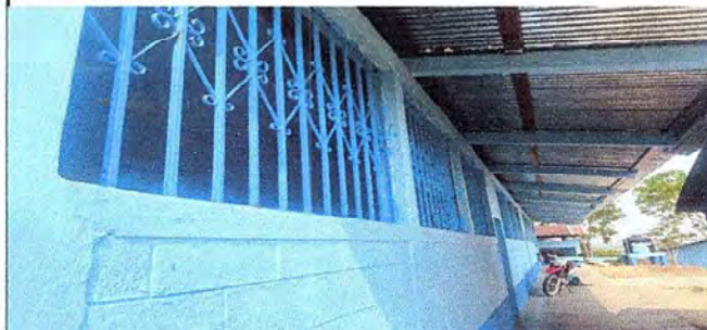
Culminacion de remosamiento de balcones del modulo numero 3
