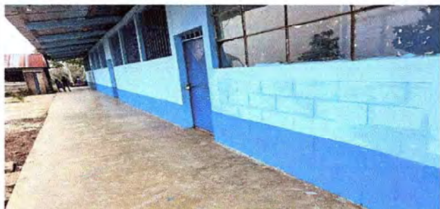
Culminacion del proyecto de pintura y remozamiento de las puertas
