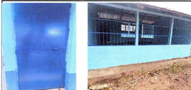
Culminacion de puesta de balcones y puertas del centro educativo la balsa
