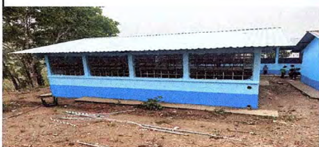
Cambio de techado de una de las aulas del modulo numero 3
