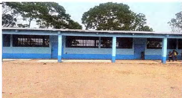
Culminacion de Pintado de interior y exterior de los modulos 1.2 y 3
